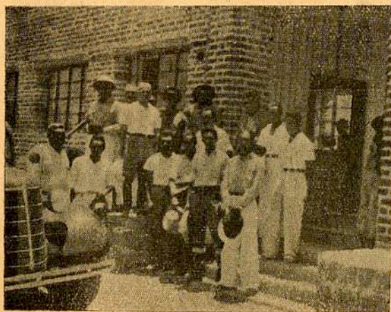
El C. Gobernador en la construcción de la misma escuela, durante una de las visitas que realizó para darse cuenta personalmente de los trabajos
