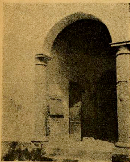
Una de las puertas de entrada antes de ser iniciadas las obras.
