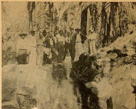
El C. Gobernador Tte. Cort. Rafael M. Pedrajo visitando el canal para riego en la Sub-delegación de San Ignacio correspondiendo esta fotografía al punto en donde se reiniciaron las obras de reconstrucción del mismo canal.
