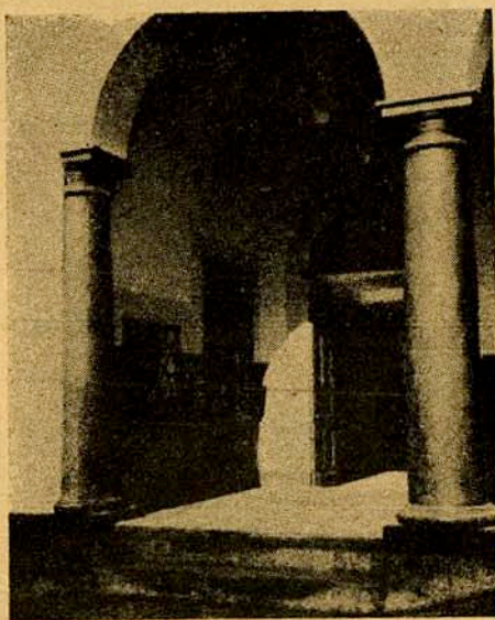
El mismo aspecto al quedar terminadas las obras de reconstrucción
