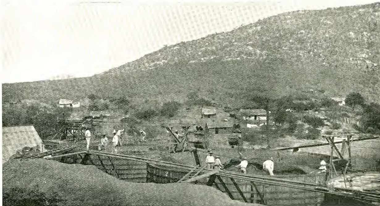
LA COMPAÑIA DE MINAS DE EL PROGRESO; TANQUES DE CIANURO. EDIFICADO POR EL PACIFIC TANK CO. DE SAN FRANCISCO. EL PROGRESO MINING COMPANY; CYANIDE TANKS. ERECTED BY THE PACIFIC TANK CO. OF SAN FRANCISCO.
