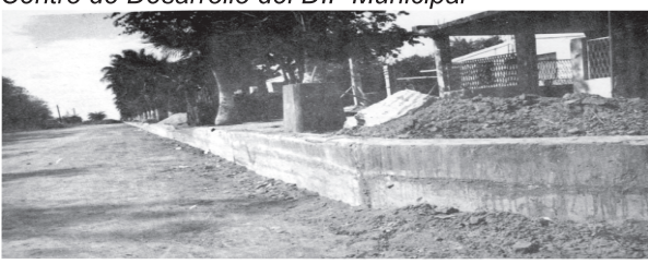
Guarniciones previas a la pavimentación
