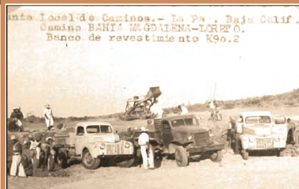
Banco de revestimiento en la construcción del camino Magdalena-Loreto en 1946. Fuente: CEI-Gob. BCS
