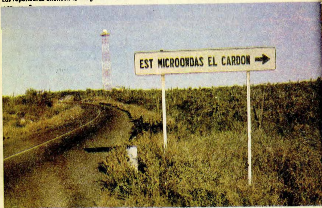
Las repetidoras difunden la imagen televisiva
